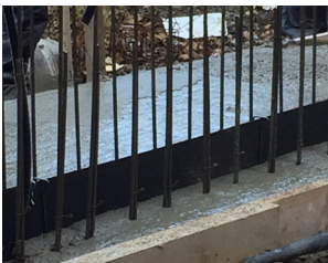
AQUAFIN-CJ5 w stanie wbudowanym.
