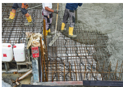
Betonowanie na AQUAFIN-WM12
